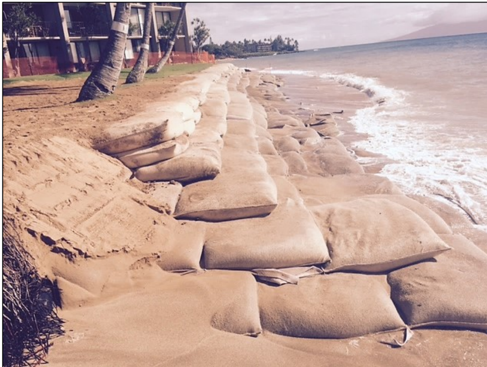
Figure 3-6 Geotextile sandbag revetment (Kahana, Maui, Hawaii)
